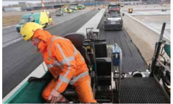
Asfaltwerkzaamheden start- en landingsbaan Groningen Airport Eelde
