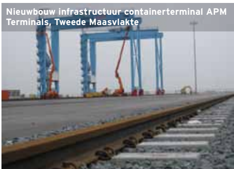
Nieuwbouw infrastructuur containerterminal APM Terminals, Tweede Maasvlakte
