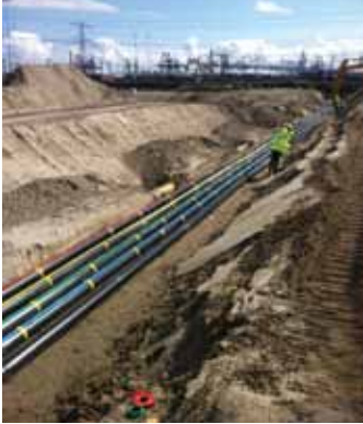
Aanleg blussysteem spoor- emplacement Maasvlakte West
