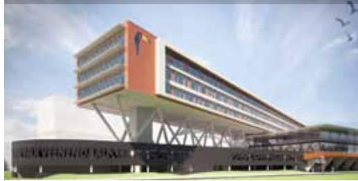
Nieuwbouw hotelcomplex Van der Valk, Veenendaal
