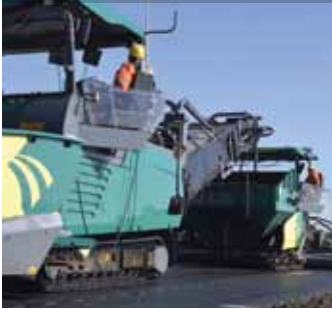
Aanleg N244, Purmerend
