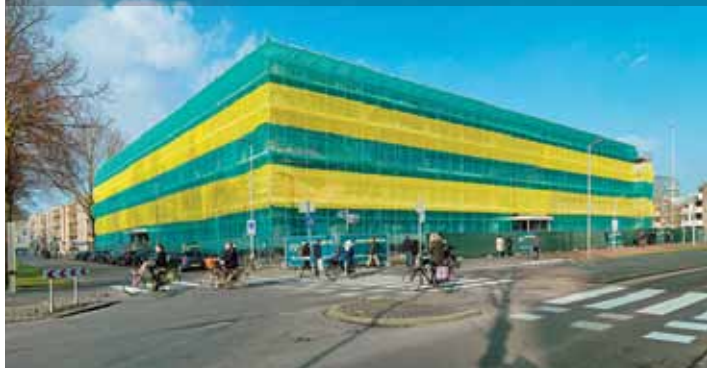
Renovatie Rabobank, Breda
