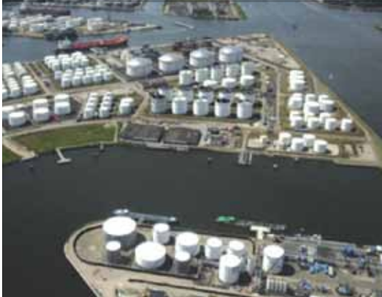
Uitbreiding en verbetering hemelwaterafvoerinstallatie Eurotank Amsterdam
