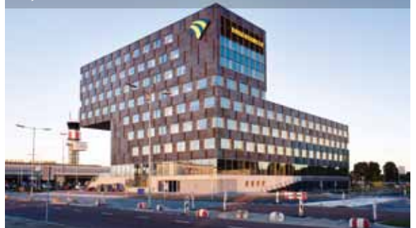
Nieuwbouw kantoor Dura Vermeer, Rotterdam The Hague Airport
