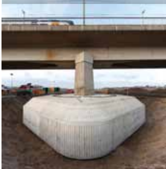
Betonfundering Ruimte voor de Waal, Nijmegen
