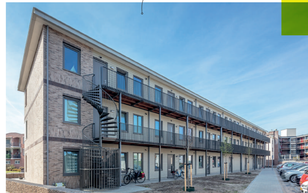
Blokje Omhoog Losser, achtergevel
