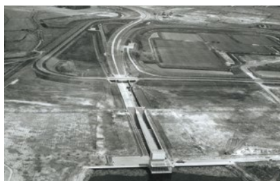
1965 Aanleg aansluitende wegen Coentunnel
