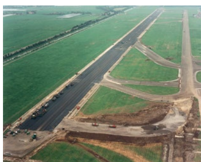
2015 Start- en landingsbaan Rotterdam The Hague Airport
