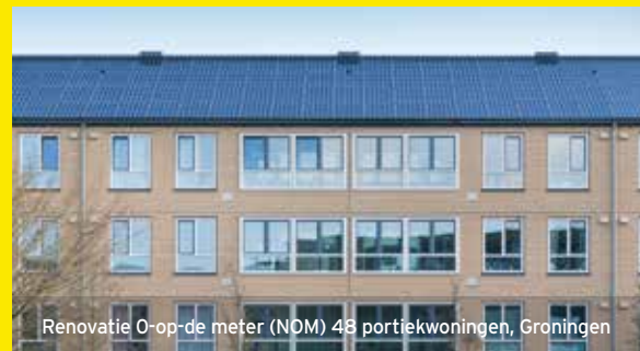
Renovatie O-op-de meter (NDM) 48 portekwoningen, Groningen
